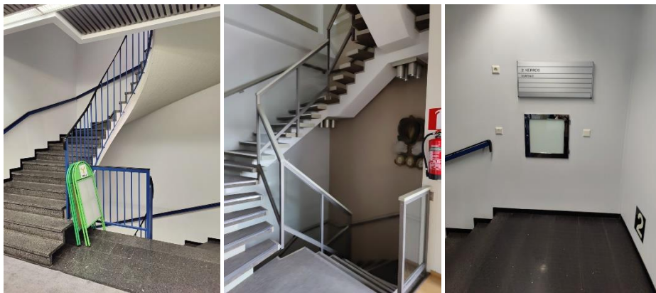
Kuva 32. (vas.) Porrashuone katutasokerroksessa. Kuva 33. (keskellä) Porrashuone myymälän yhteydessä katutasokerroksessa, tila 128. Kuva 34. (oik.) Porrashuone 2. kerroksen kohdalla.
