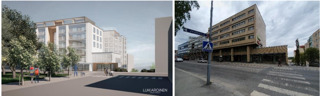
Kuva 18 Kuvassa näkymä Porrassalmenkadulta kohti järveä nykyisin ja asemakaavan pohjaksi laaditun viitesuunnitelman mukaisena. Kaupunkikuvallisesti merkittävin muutos on alapihan 8-kerroksinen rakennusmassa. Porrassalmenkadun ja Savilahdenkadun kulmaus säilyy avarana.
